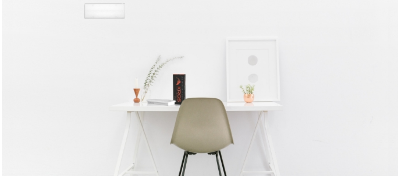
L'immagine soprastante rappresenta la lampada FAST installata con scatola ad incasso.
